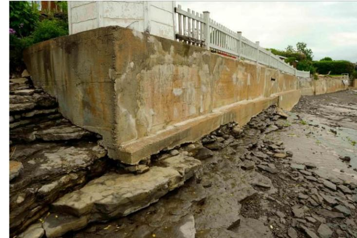
Aux extrémités de la zone d'intervention, on retrouve de rives protégées par des murets de béton. On constate l'érosion importante des plaques schisteuses. Naturellement, la rigidité des murs n'est pas compatible avec la modification du fond.
