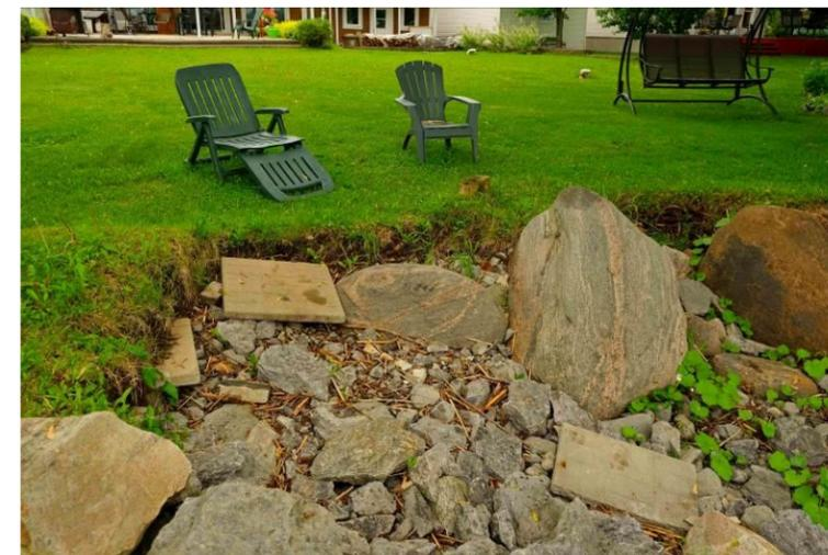
Projet Restauration d'une rive constituée d'un enrochement altéré
