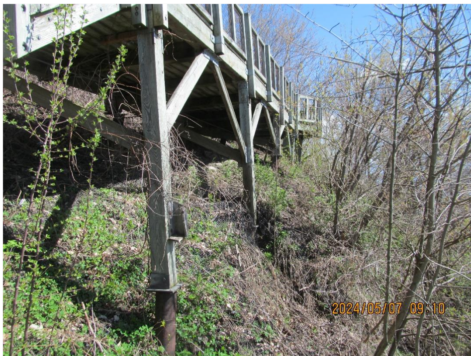
Photographie 8 : Pieu incliné. (2024-05-07)
