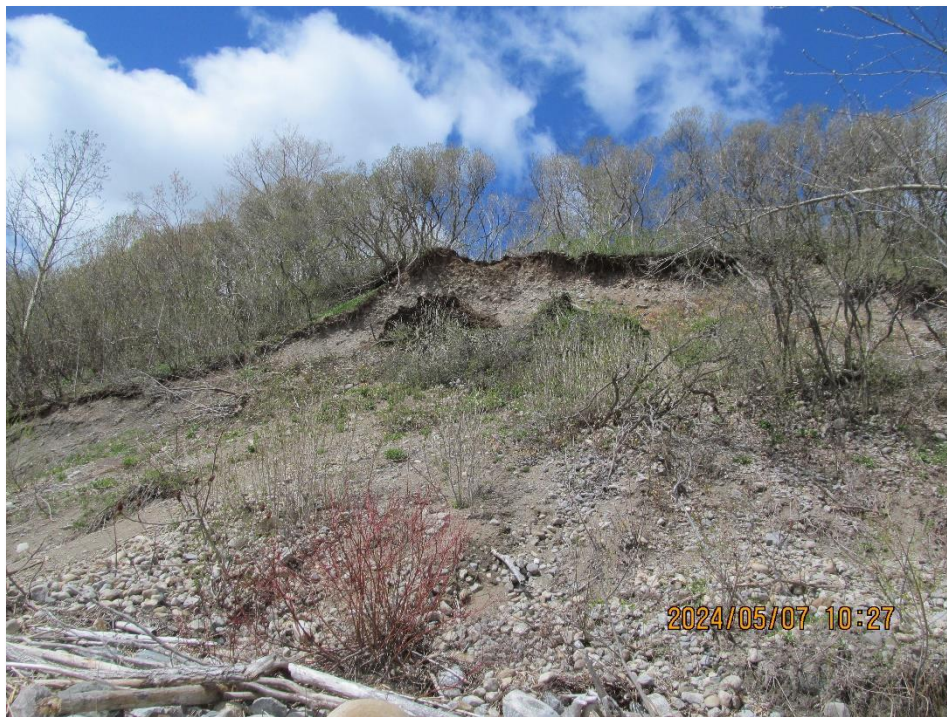
Photographie 11 : Talus, partie est. (2024-05-07)
