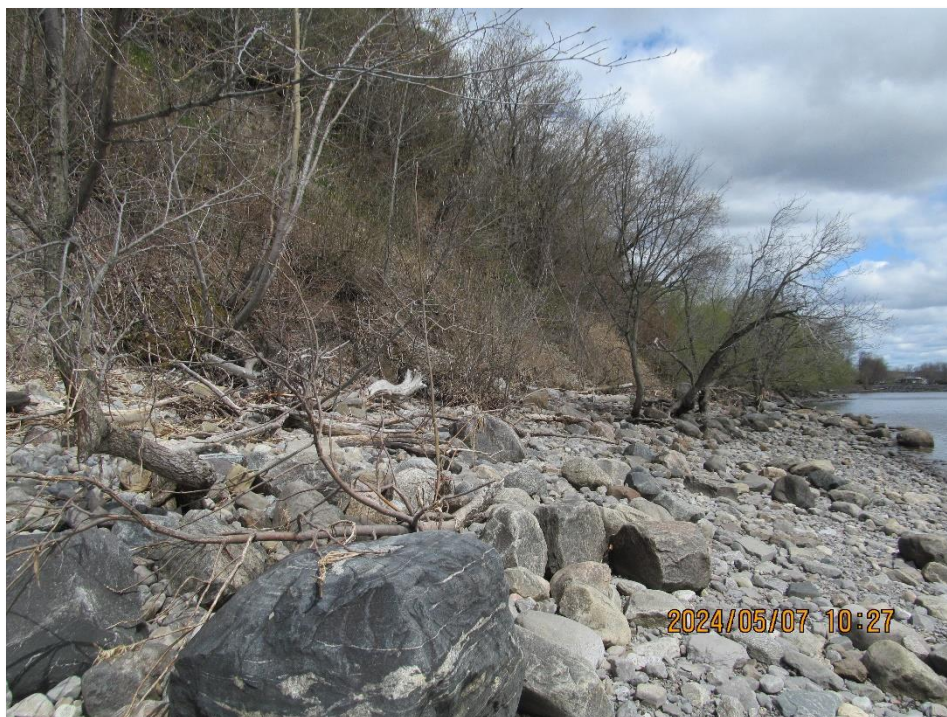
Photographie 14 : Cailloux et blocs au pied du talus. (2024-05-07)
