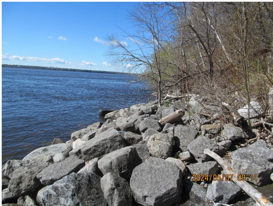
Photographie 7 : Enrochement de rive, partie ouest. (2024-05-07)
