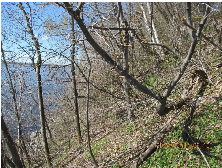
Photographie 6 : Pente du talus, partie ouest. (2024-05-07)
