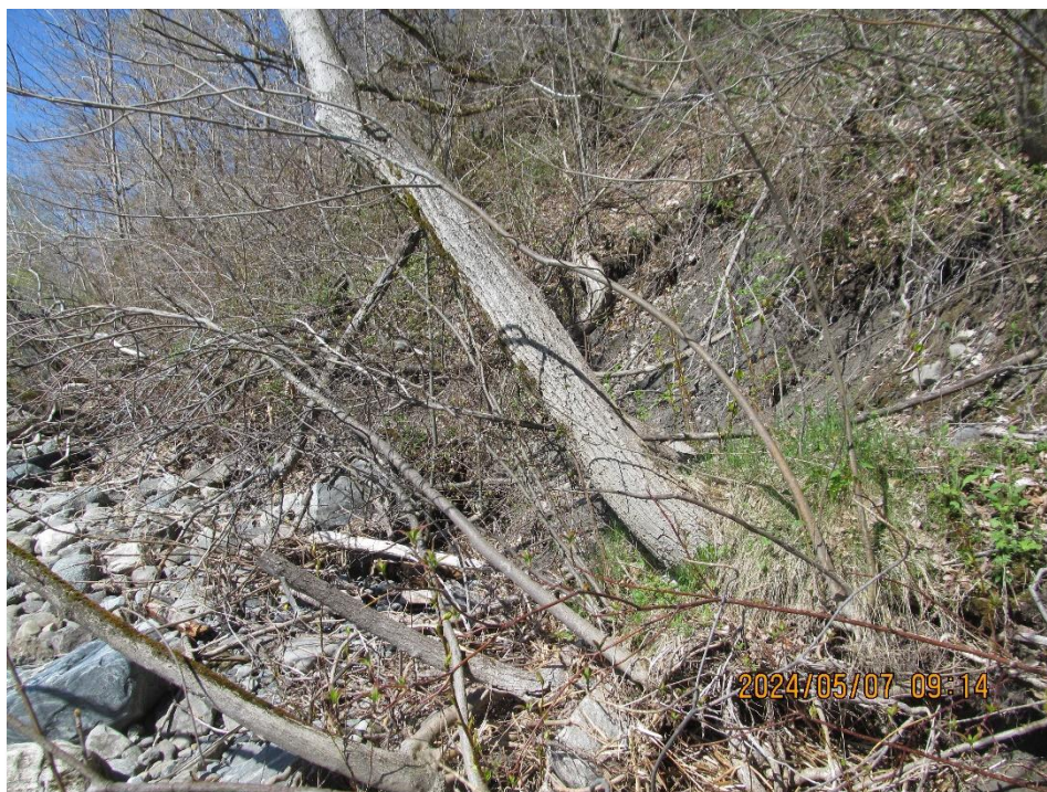
Photographie 10 : Côté est de l'escalier, décrochement. (2024-05-07)
