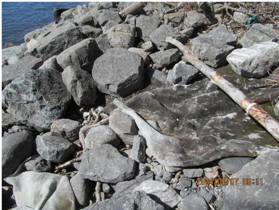
Photographie 9 : Géotextile sous l'enrochement. (2024-05-07)
